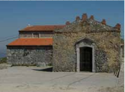
Serra de Montejunto GPS: 39.174849, -9.059367 ☎ (+351) 916 371 944 Visitas sob marcação prévia Visits under prior appointment.
